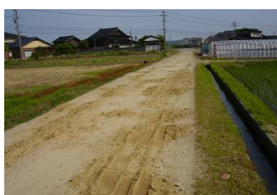
農道補修の作業後写真
