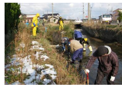
江堀りの状況写真
