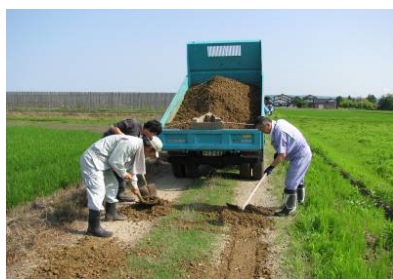
農道補修の状況写真
