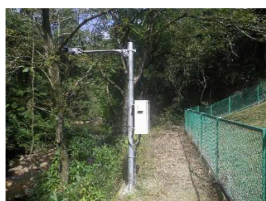
(ダム隧道・カメラ)
