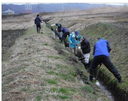
農業水路の江掘り
