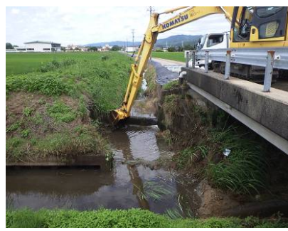
余喜承水溝浚渫（余喜地内）
