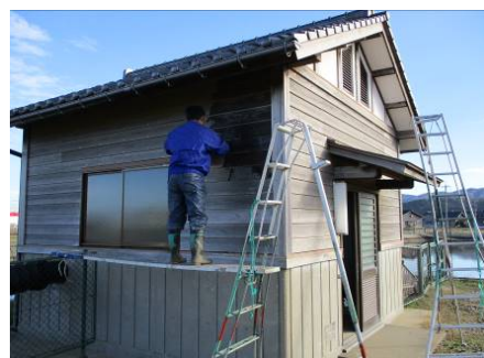
用水機上屋塗装（太田町）
