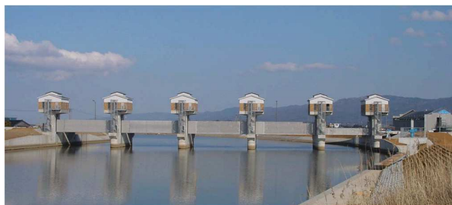
羽咋川潮止水門
