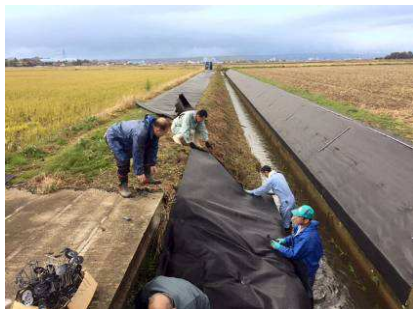
防草シート敷設（粟生）
