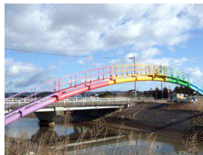
送水管塗装工事（吉崎）
