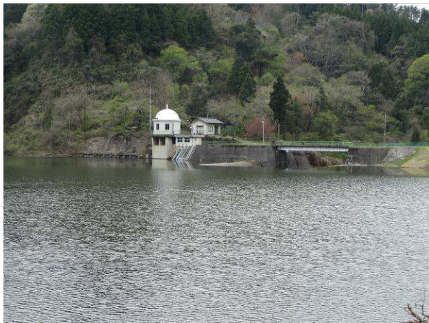
子浦川防災ダム（宝達志水町下石）
