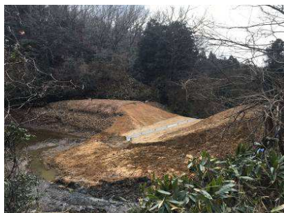
溜池堤体切削（千路）
