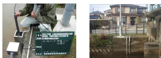
◆不動用水堰水位計設置工事（2,000 千円）
